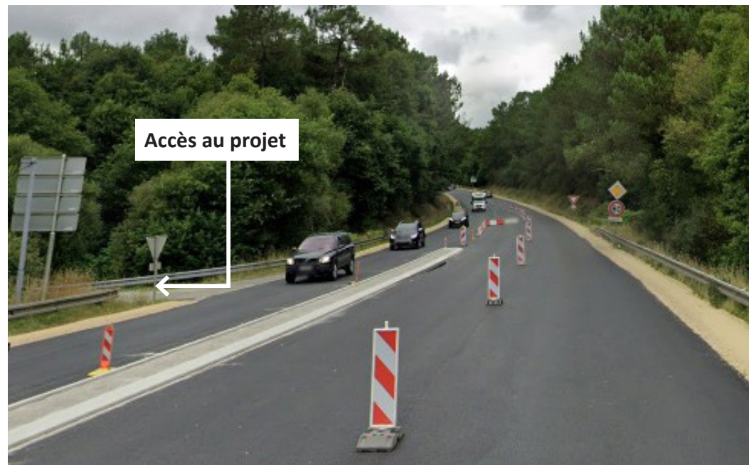
Photographie google datant de 2020 pendant les travaux de création du terre plein
